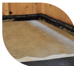
Colocación de colchonetas acústicas
